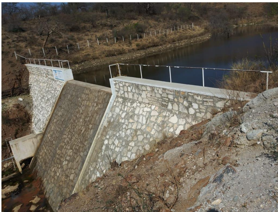
Cortina de presa en El Carrizo (Abril, 2019)
