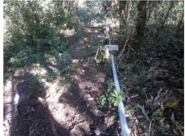
Fotografía 3. Obra de toma sin válvula de paso y línea de conducción con mezcla de cemento para la sujeción de la tubería
