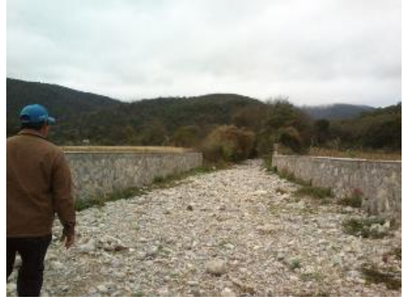
Fotografía 14. Muro de mampostería para conducir el flujo superficial
