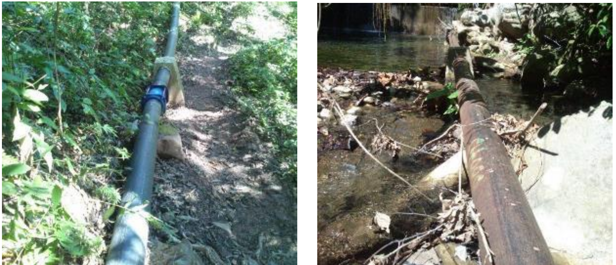
Fotografía 19. Línea de conducción utilizando tubos de 6 pulgadas
