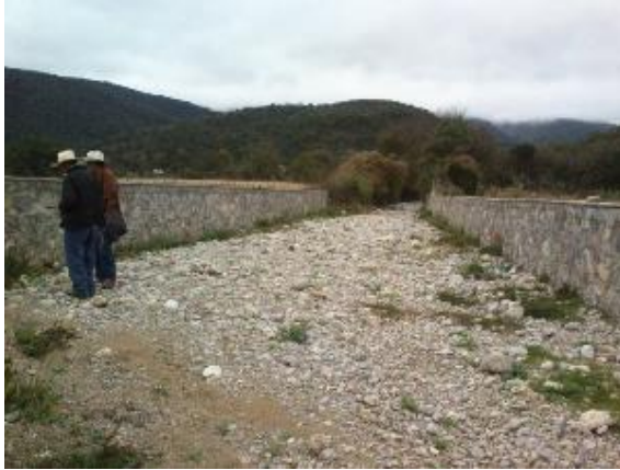
Fotografía 14. Muro de mampostería para conducir el flujo superficial
