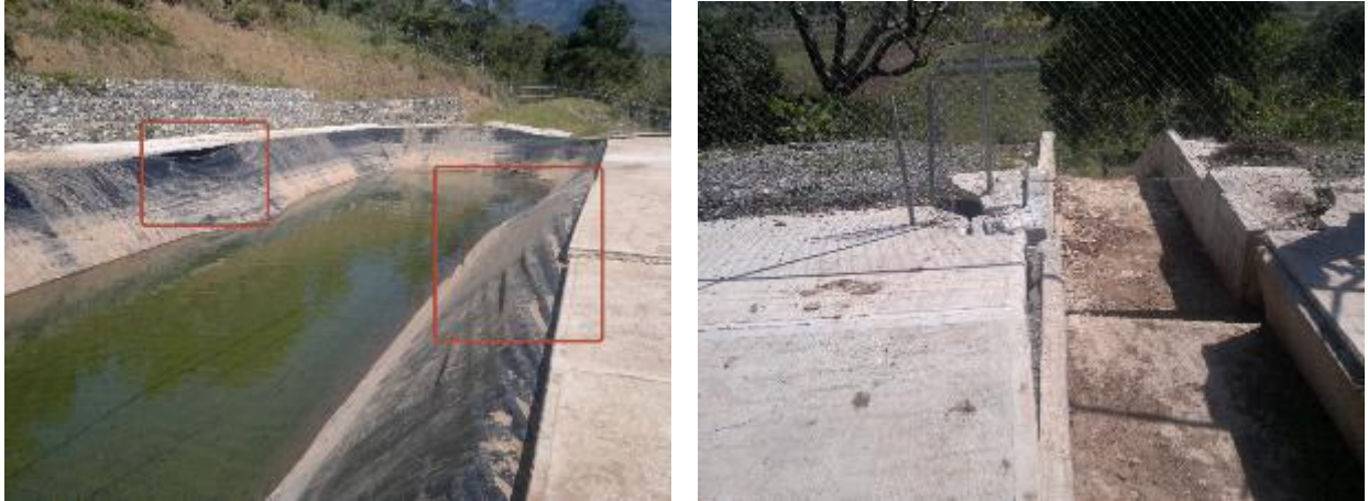
Fotografía 18. Situación actual de la olla de agua
