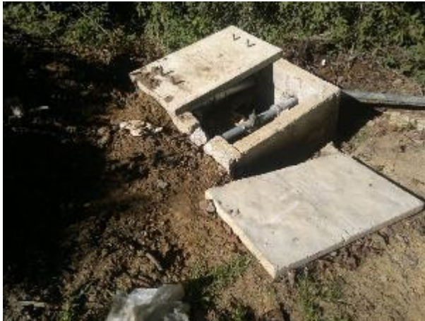
Fotografía 3. Obra de toma sin válvula de paso y línea de conducción con mezcla de cemento para la sujeción de la tubería
