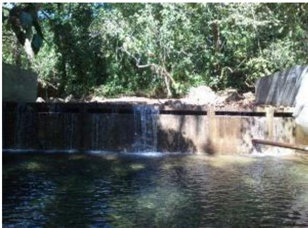
Fotografía 16. Caja de captación en funcionamiento
