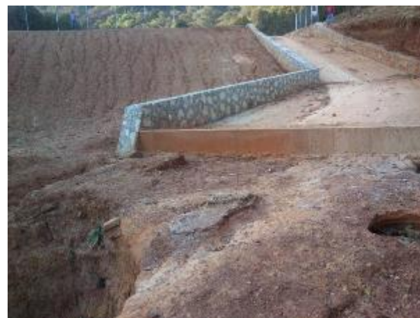
Fotografía 7. Bordo de tierra compactada con problemas de construcción
