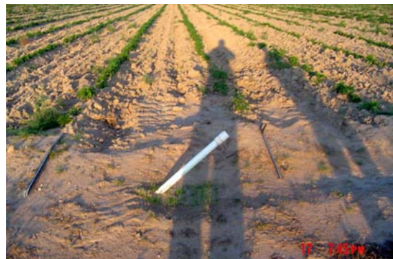
Purga de aire de tubería lateral
