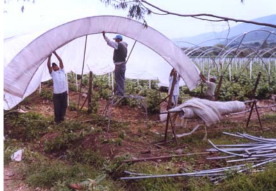
Colocación de plástico para formar el túnel
