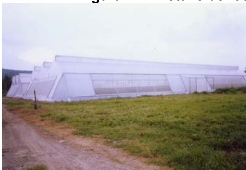
Invernaderos apoyados 1 y 2 (de izq. a der.)
