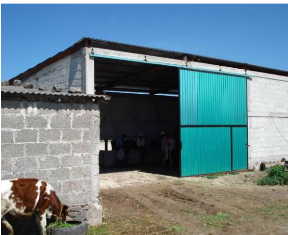
Vista frontal de bodega
