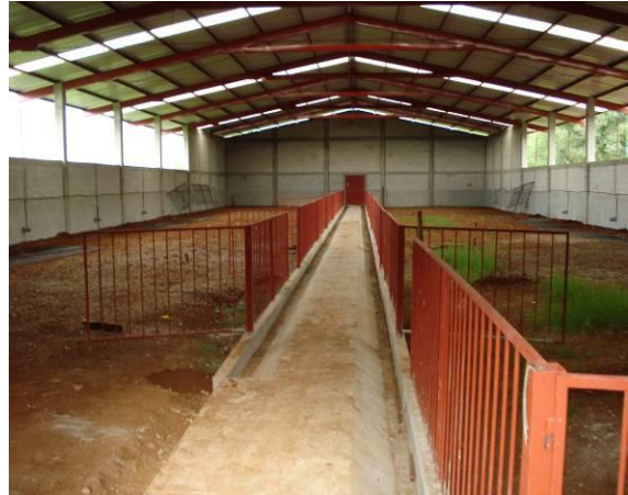
Vista interior del corral (subdivisiones)
