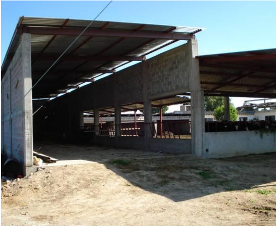
Vista frontal de bodega
