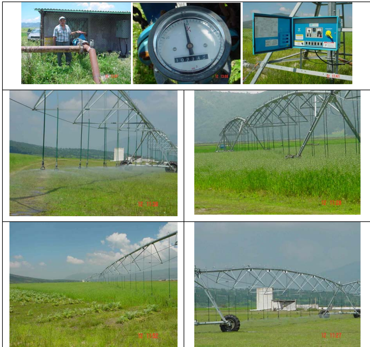
Figura Anexo 3.2. Vistas del sistema de Pivote Central
