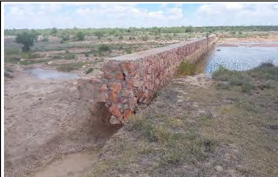
Daño en base de bordo de contención a base de mampostería
