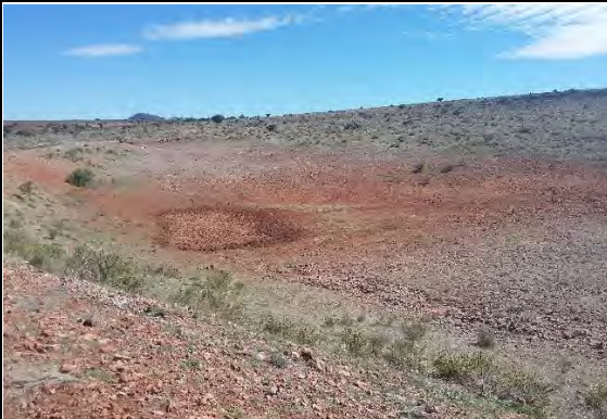
Alto nivel de azolve por no funcionalidad de obras secundarias aguas arriba
