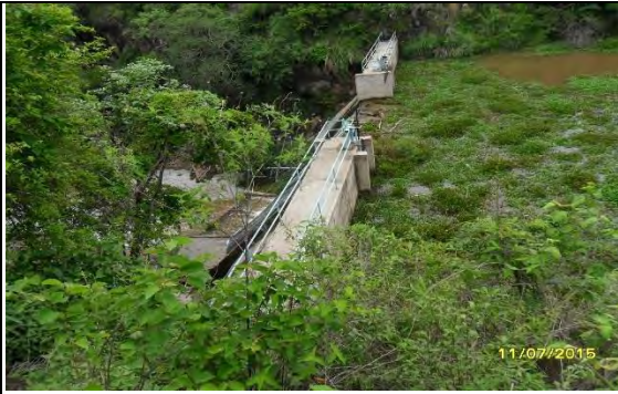
Alto nivel de azolve por no funcionalidad de obras secundarias aguas arriba
